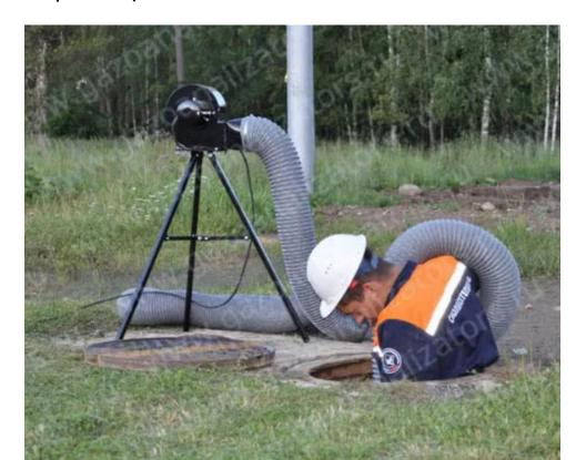
Перед допуском работников к выполнению работ в ОЗП все работающее от приводов оборудование в замкнутом пространстве и источники питания должны быть выключены, а соответствующие выключатели на распределительном щите - заблокированы и снабжены предупреждающими знаками.
